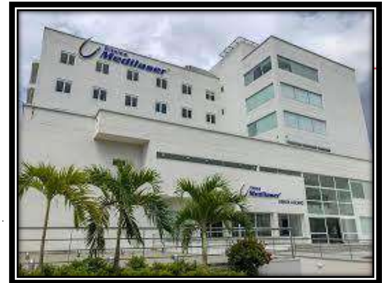
CONSTRUCCIÓN CLÍNICA MEDILASER ABNER LOZANO Neiva
